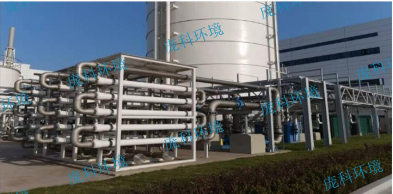
脱氮的膜生物反应器及其污水脱氮方法，用垂直导流挡板，并结合曝气装置把膜生物反应器依次分割成第1缺氧池、好氧池、第二缺氧池、厌氧池、膜池五个单独且连通的反应器室；污水进入工艺后，经微生物作用，完成有机物的降解、硝化、反硝化等生化处理过程，较终通过膜过滤抽吸获得出水。益处是整个系统中污泥混合液以平推流的形式流动，而在单个隔间内呈全混流态，加之回流装置使得整个反应器混合度高，传质效果好；该工艺在不额外投加碳源的情况下，利用高污泥浓度强化内源反硝化作用，实现深度脱氮处理，而且可减轻膜污染；同时利用膜的高效截留分离特性，过滤出水水质良好。甘肃好氧脱氮反应器在哪买高负荷好氧脱氮膜反应器系统设备少，故障率低，外置式膜美观整洁，便于维护。
